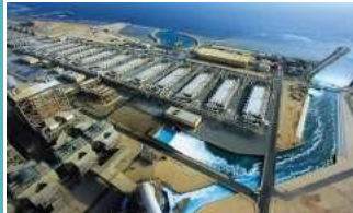
Usine de dessalement en Arabie saoudite.
